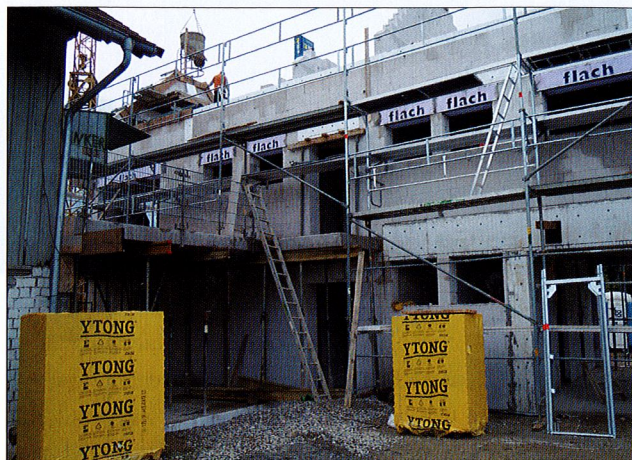
Haus für Saisonarbeiter wird gebaut
